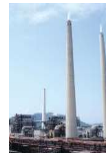
自家発電設備
