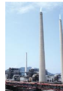
自家発電設備
