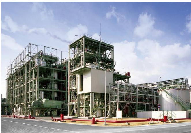
イソシアネート製造プラント
