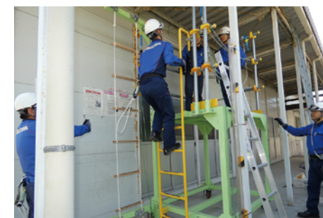
高所作業における危険体感設備
