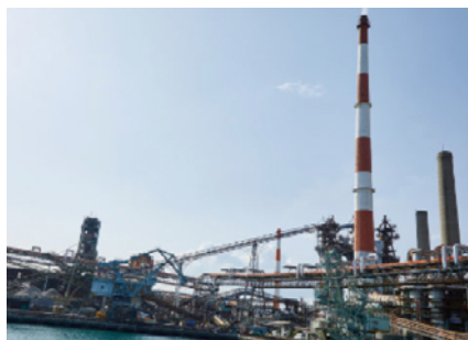
セメントプラント
