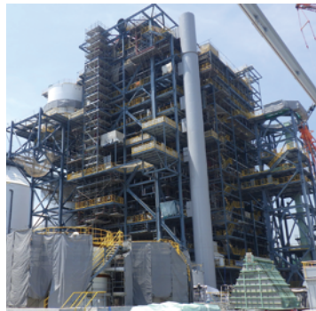
バイオマス発電設備（建設中）
